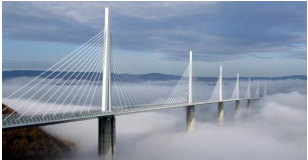
Grande Viaduc de Millau - ein Bauwerk der Superlative. Die 2460 Meter lange Schrägseilbrücke liegt im Süden des französischen Zentralmassivs westlich der Stadt Millau und ist die höchste Autobahnbrücke der Welt. (Quelle: http://www.zdf.de/ZDFmediathek/beitrag/bilderserie/112560/Moderne-Bruecken-Konstruktionen#/beitrag/bilderserie/112560/Moderne-Bruecken-Konstruktionen )
